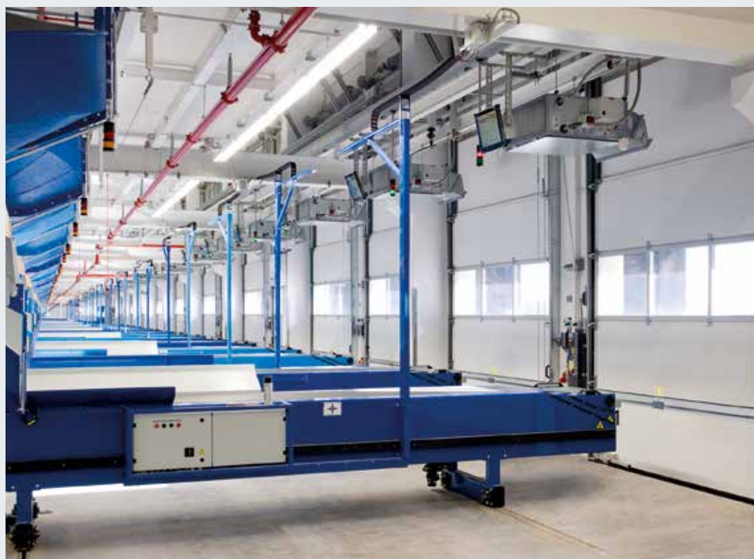
De deelbare industriedeur werd speciaal ontwikkeld voor logistieke centra bijv. van pakketdiensten.
